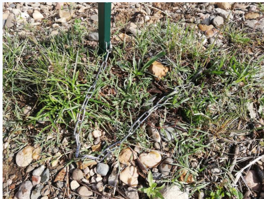
Système d'ancrage des panneaux
